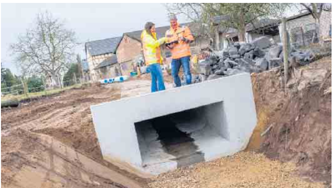
Mit dem neuen, groß dimensionierten Rechteckprofil können nun 2000 bis 3000 Liter Wasser aus der Graf-Schall-Straße in Antweiler abgeleitet werden. Foto: Ronald Larmann/pp/Agentur ProfiPress
