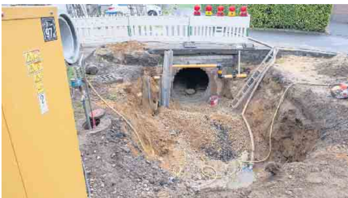
Kürzlich wurde in der Koloniestraße in Antweiler mit den Arbeiten begonnen. Der Durchlass unter der Straße wurde bereits vergrößert, weil künftig Kanalrohre mit einem Durchmesser von 1200 verbaut werden. Foto: Ronald Larmann/pp/Agentur ProfiPress
