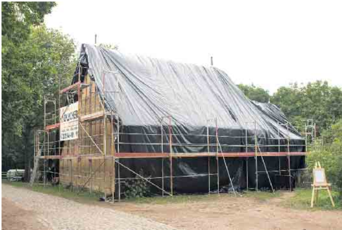
Bereits im September 2010 wurden schon einmal Fachwerkgebäude des Eifeler Freilichtmuseums in Mechernich mit Thermotherapie von Holzwürmern befreit. Foto: pp/Archiv ProfiPress
