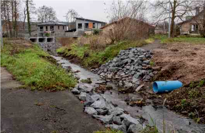
An dieser Stelle wird die Stahlbrücke die im hinteren Bereich durch einen Neubau ersetzt wird, wiederverwendet. Das blaue Rohr ist eine neue Entwässerung für die Brochgasse. Foto: Ronald Larmann/pp/Agentur ProfiPress
