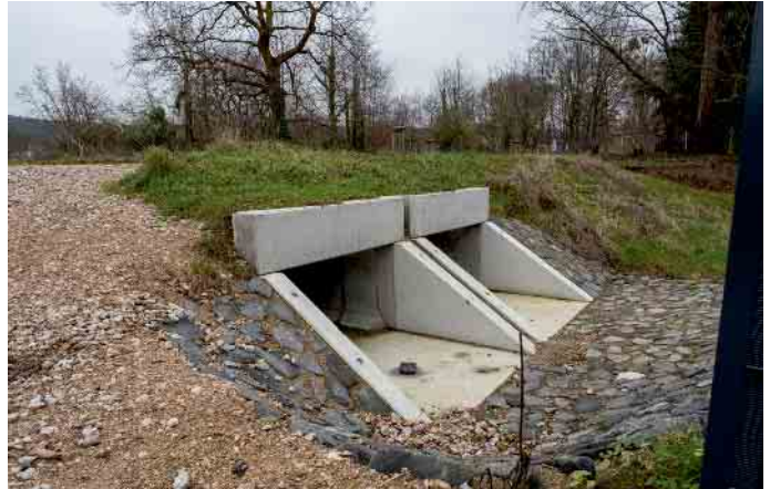
Ein großer Durchlass wurde in der Verlängerung des Bahnhofswegs inzwischen fertiggestellt. Foto: Ronald Larmann/pp/Agentur ProfiPress
