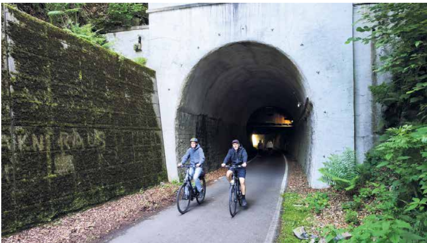
Der Krommenohler Tunnel, ein 90 Meter langer, ehemaliger Eisenbahntunnel in Marienheide. Foto: R. Garburg
