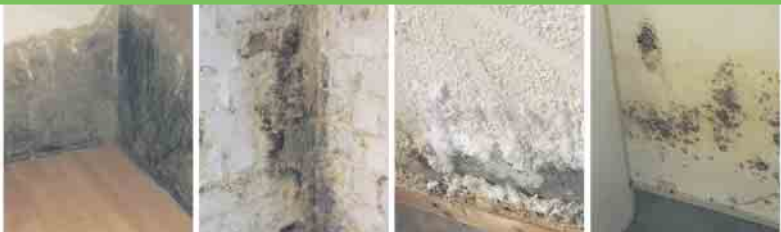
Defekte Horizontalsperre Querdurchfeuchtung Ausblühungen Schimmelbefall
