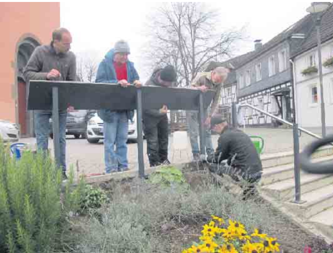
Montagearbeiten am Rande des Kirchplatzes
