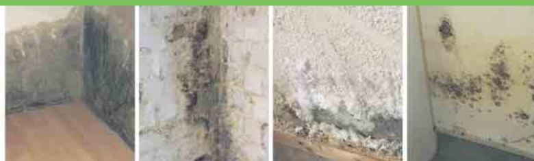
Defekte Horizontalsperre
