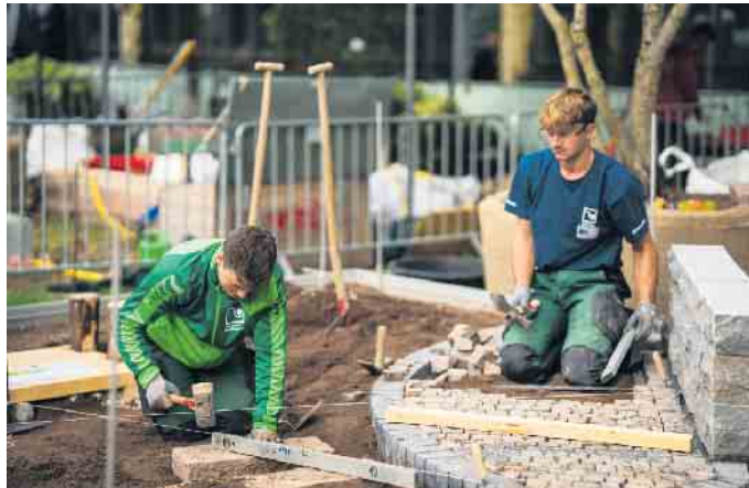
Bei der kunstvollen Verlegung von Pflastersteinen für Wege oder kleinere Plätze ist Teamarbeit und Handwerkskunst gefragt. Foto: AuGaLa/Jonas Nelke
