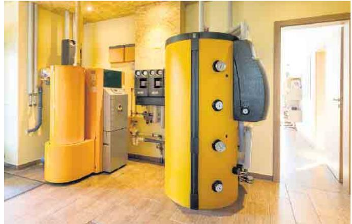
Bei neuen oder energetisch sanierten Ein- oder Mehrfamilienhäusern sollten die Vorteile der Nutzung von Holzwärme wie mit einem Pelletkessel nicht übersehen werden. Ein modernes Abgassystem gehört dann in jedem Fall mit dazu. Foto: DJD/Allianz Freie Wärme/U. Seidel
