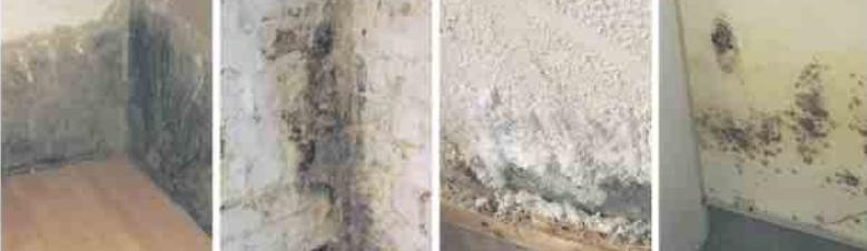
Defekte Horizontalsperre    Querdurchfeuchtung    Ausblühungen    Schimmelbefall
