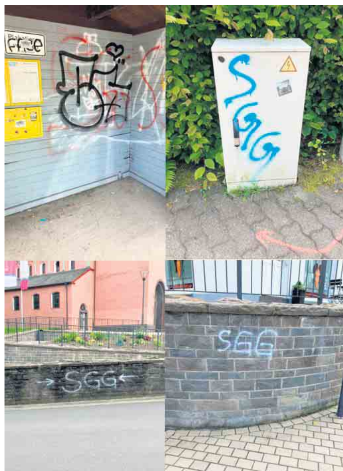
Schmiererei an der Kirchmauer Much / Bushaltestelle Gippenstein / Stromkasten Zanderstraße
