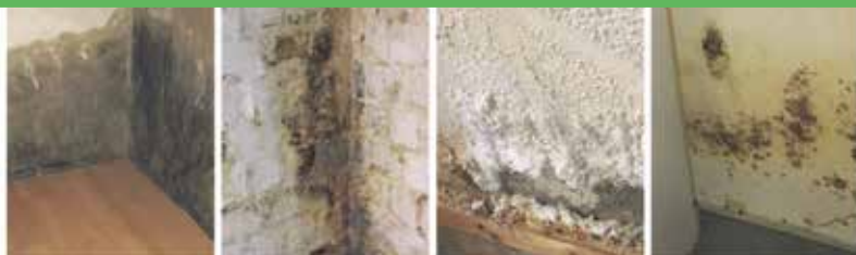
Defekte Horizontalsperre
