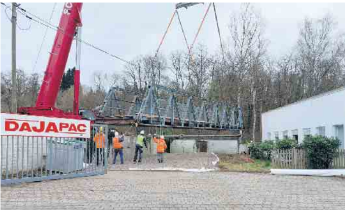
Die Brücke wurde mit einem Kran in Gänze entnommen und auf das angrenzende Firmengelände gehoben, um sie dort in Einzelteile zu zerlegen und letztlich entsorgen zu können.
