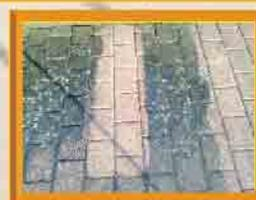
**Wir arbeiten mit einem Hochdruckreiniger mit 80% Luft und 20% Wasser.**
