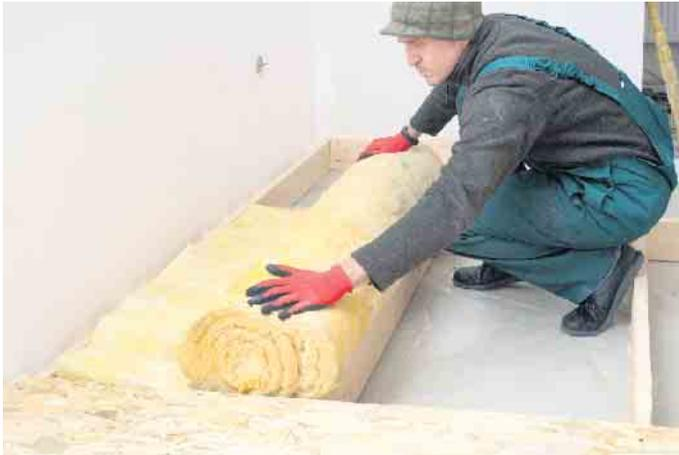
Eine Dämmung aus Mineralwolle senkt den Energieverbrauch und die damit verbundenen Kosten eines Gebäudes bei gleichzeitig verbessertem Schall- und Brandschutz. Einfache Maßnahmen können in Eigenregie durchgeführt werden.
