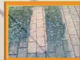
Wir arbeiten mit einem Hochdruckreiniger mit 80% Luft und 20% Wasser.
