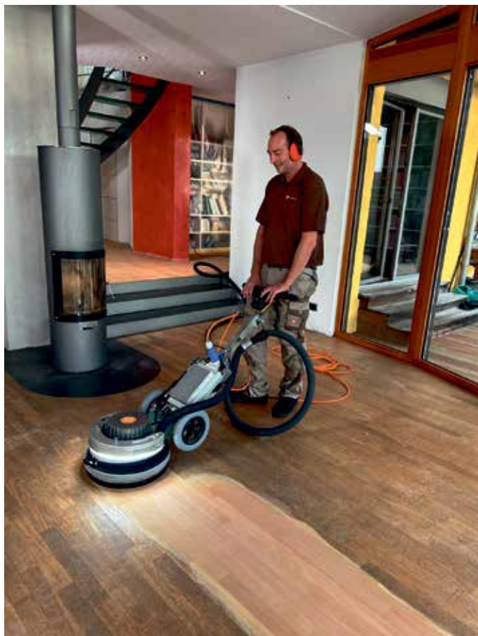
Nach einem Abschleiff glänzt Parkett wieder wie neu. So kann es viele Jahrzehnte verwendet werden. Foto: Pallmann
