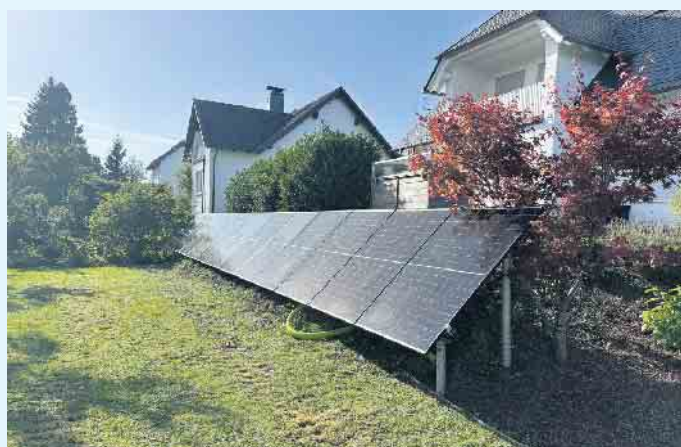
PV-Anlage auf der Rasenanlage - eine Montage muss nicht immer zwingend auf dem Dach erfolgen
