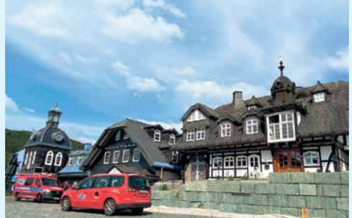
Der Meisterbetrieb Menke in Winterberg-Siedlinghausen
