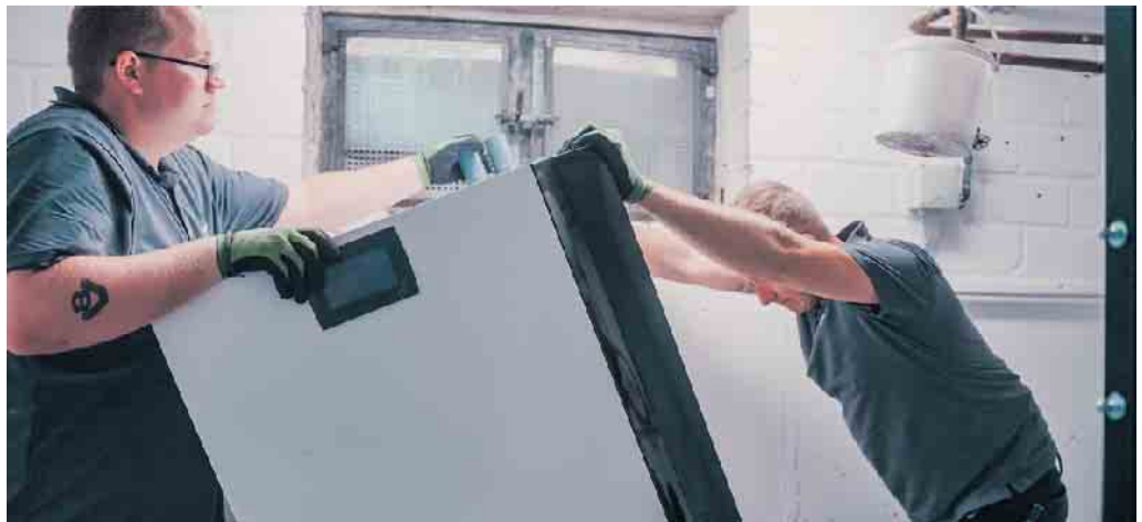
Montage des Pelletkessels. Foto: depi
