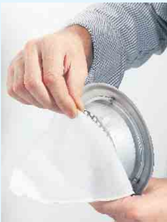
Damit das Lüftungssystem effizient arbeitet, sollten die Filter mindestens einmal im Jahr überprüft und ausgetauscht werden. Foto: DJD/Initiative Gute Luft
