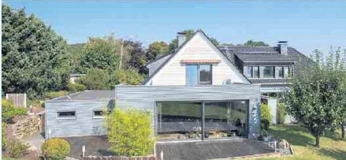
Maßgeschneiderter Anbau in Holzbauweise sowie Aufstockung, vorher und nachher
