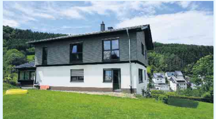
Nach der Aufstockung mit Holzbauweise, Putz- und Holzfassade, Satteldach und neuer Etage
