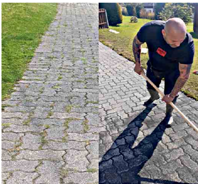
Reinigung von Fugen vorher und nachher.
