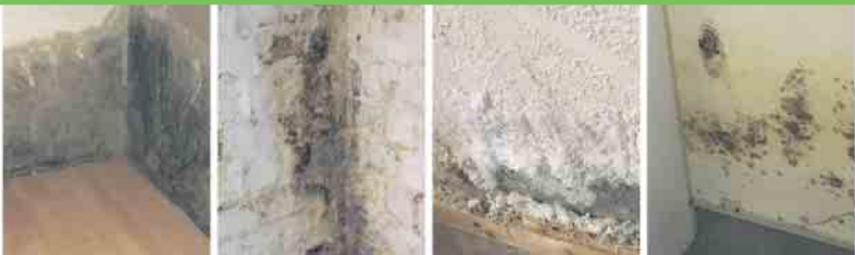
Defekte Horizontalsperre Querdurchfeuchtung Ausblühungen Schimmelbefall
