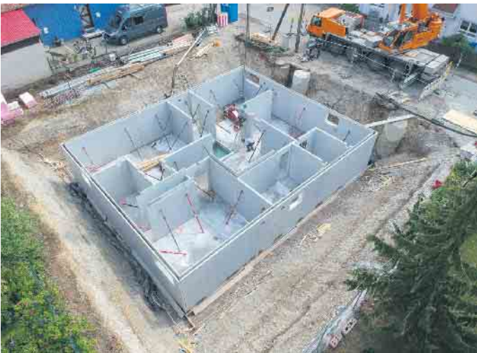
Ein Fertiggeller wird aus industriell vorgefertigten Bauteilen errichtet. Foto: GÜF/Knecht Kellerbau
