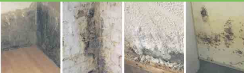
Defekte Horizontalsperre
