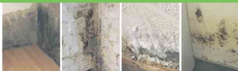
Defekte Horizontalsperre
