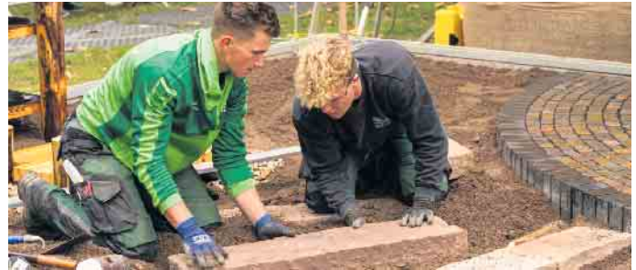
Bei der Verlegung von Trittstufen ist handwerkliches Geschick und Teamarbeit gefragt. Fotos: AuGaLa/Reidel
