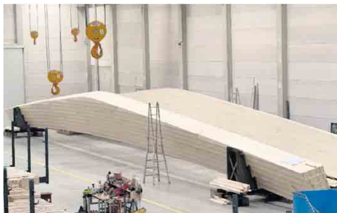
Die Brücke nimmt Gestalt an. Hier ein Eindruck aus der Fertigungshalle (Ingenieurbüro Miebach)
