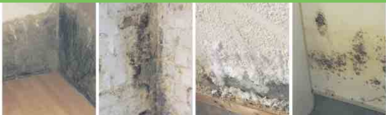
Defekte Horizontalsperre Querdurchfeuchtung Ausblühungen Schimmelbefall
