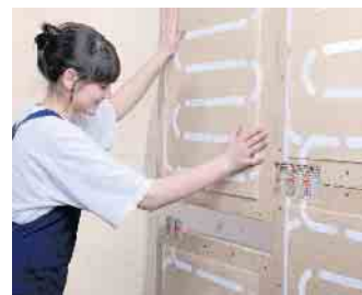
Eine angenehme und energiesparende Wandheizung ist mit Lehmputzplatten, die ab Werk mit Heizungsrohren vorbestückt sind, schnell und einfach einzubauen. Foto: DJD/Naturbo
