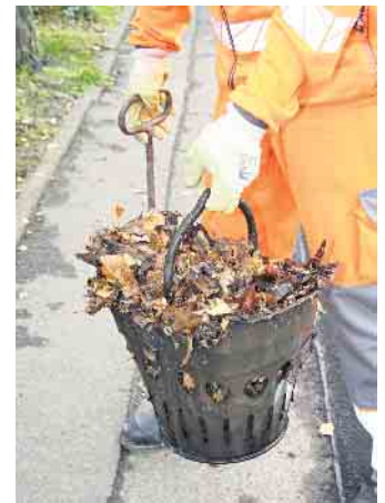
Unter den Kanaldeckeln befinden sich sogenannte „Senkeimer“ aus Metall, in denen sich Laub, Geröll und Schmutz sammeln. Foto: Alice Gempfer/Gemeinde
