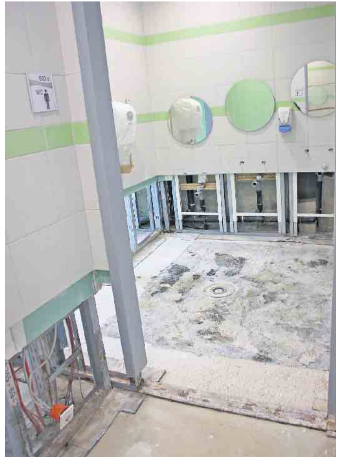
Auch im Sanitärbereich wurden Estrich, Putz und Teile der Trockenbauwände rückgebaut sowie alle Armaturen entfernt. Foto: Alice Gempfer/Gemeinde Kall
