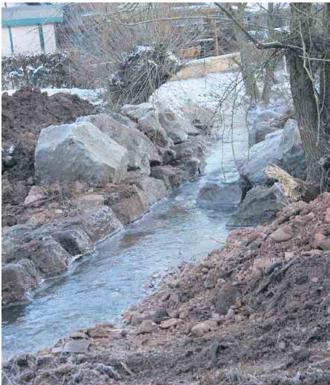
Eine erste Reihe an Gesteinsbrocken dient als Fundament, darüber wird eine zweite verlegt. Foto: Alice Gempfer / Gemeinde Kall
