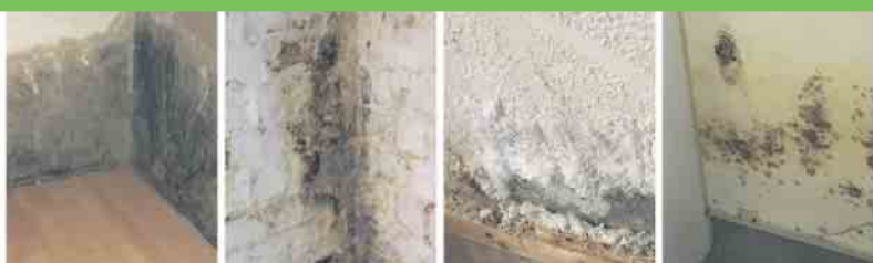
Defekte Horizontalsperre
