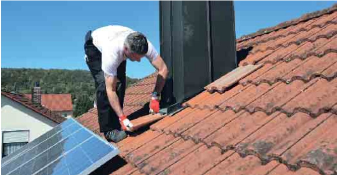
Anschlüsse an Dachdurchdringungen werden beim DachCheck begutachtet. Foto: HF Redaktion/akz—o
