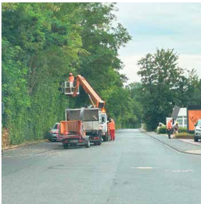
Fertigstellung der Teststrecke
