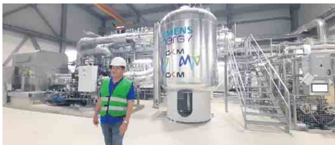
Flusswasserwärmepumpe im Großkraftwerk Mannheim (Foto: Katja Stoppenbrink)
