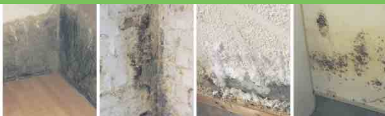
Defekte Horizontalsperre
