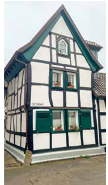
Ein denkmalgeschütztes Haus in der Winkelgasse der Altstadt von Königswinter
