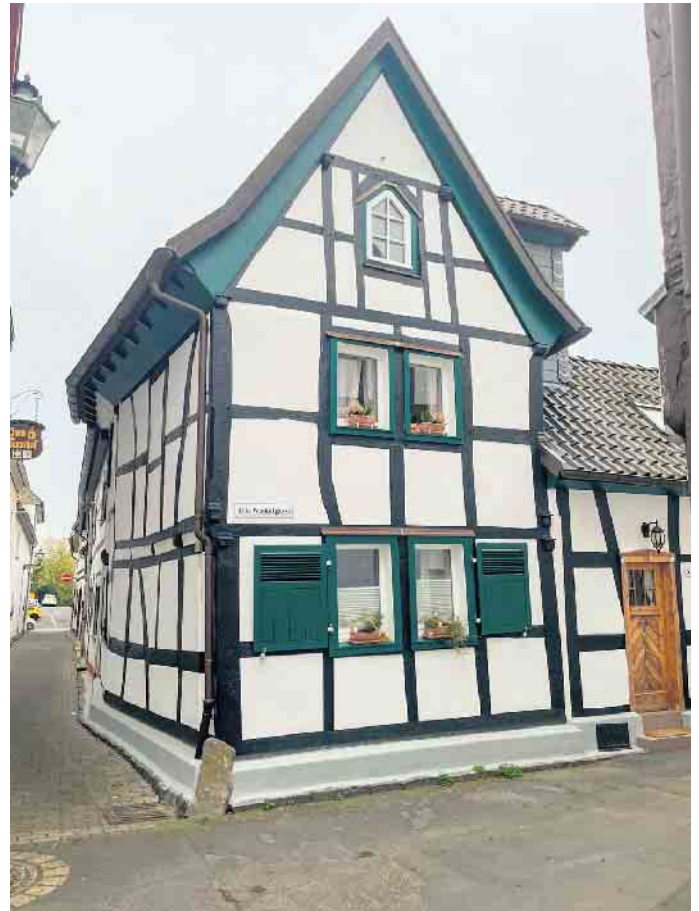
Ein denkmalgeschütztes Haus in der Winkelgasse der Altstadt von Königswinter
