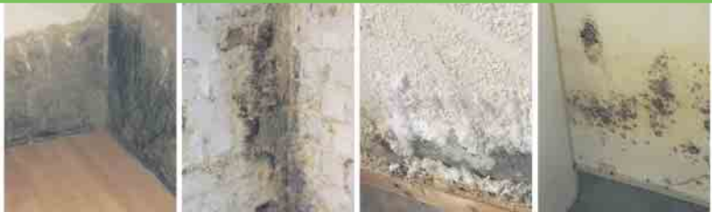
Defekte Horizontalsperre Querdurchfeuchtung Ausblühungen Schimmelbefall
