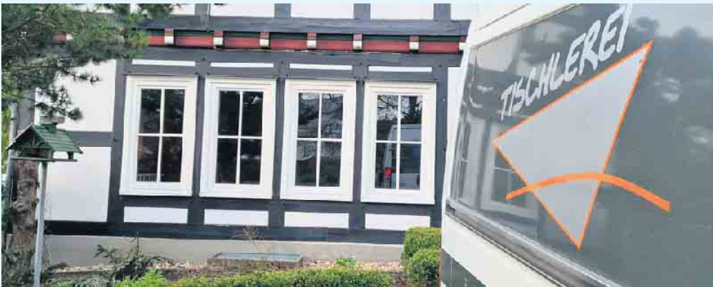
Neue Fenster von der Tischlerei Holztec
