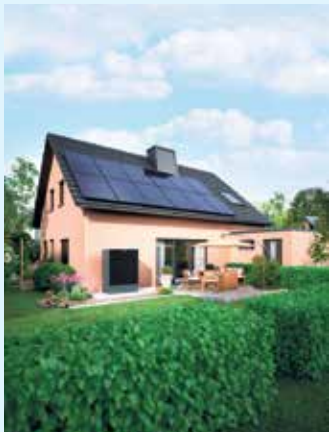
Einfamilienhaus mit modernen Full-Black-Modulen für optimale Aufnahme der Sonnenenergie
