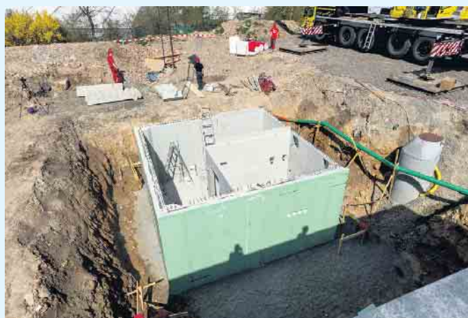
6,50 mal 6,50 Meter Baugrube reichen für einen kompakten Teilkeller meist schon aus. Foto: GÜF/Glatthaar Keller
