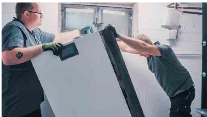
Montage des Pelletkessels. Foto: depi
