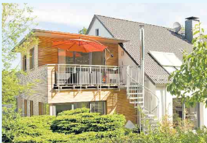
Haus nach dem Anbau
