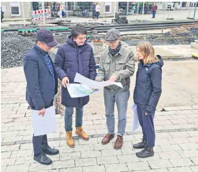
Foto: Michael Walter, Mario Dahm, Johannes Oppermann und Karen Busche an der Baustelle des Fontänenfeldes auf dem Marktplatz
