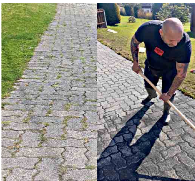
Reinigung von Fugen vorher und nachher.
